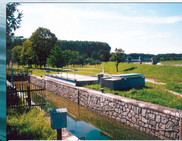
Plavební komora Vnorovy II.
